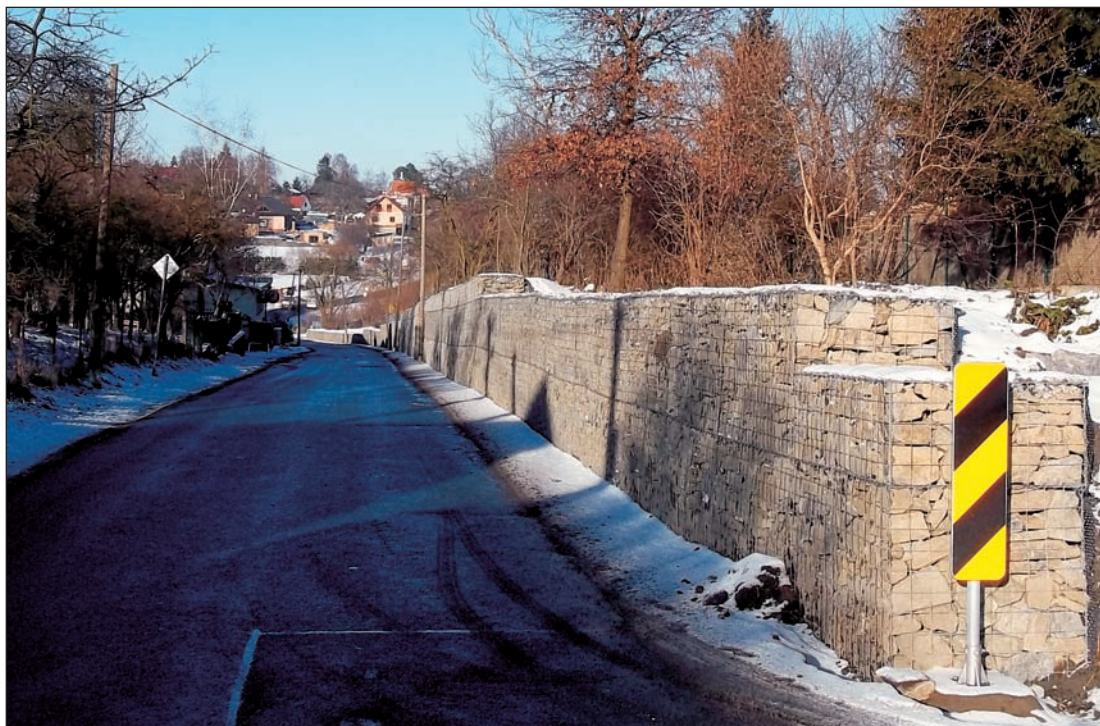
Nová zeď naproti restauraci „U Fousků“ ve Vidovicích (investor Středočeský kraj)
