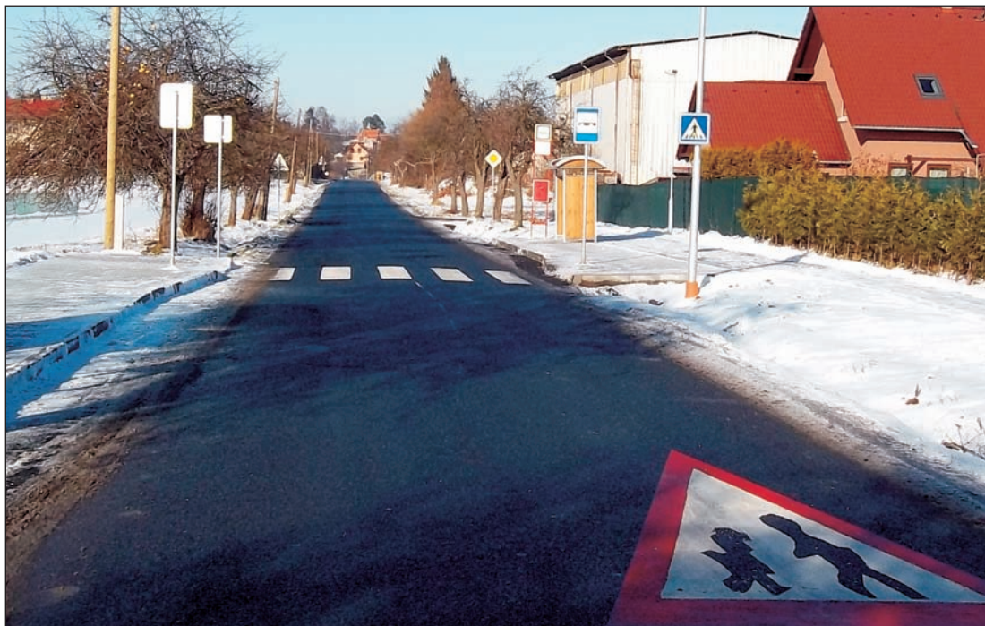
Nové zastávky a přechod ve Vidovicích
